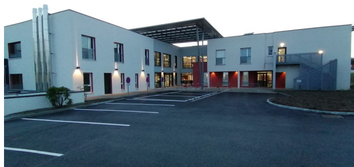
EHPAD La Résidence de la Porte du Puycharraud (fin des travaux décembre 2020)
